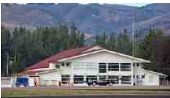
AdP convoca Licitación Pública Internacional para la Adquisición de Equipamiento para Cableado Estructurado y para el Sistema de Comunicación en seis aeropuertos del país
